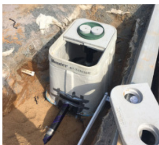
Polymerbetonkasten für ST-1600B, inkl. Wasserschnellkupplung und Wahlschalter Hand/Auto/Aus BxLxH: 61x91x91cm Gewicht: 138kg
